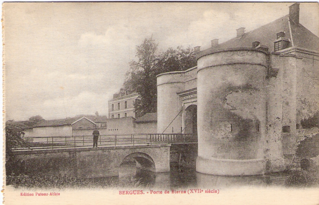
BERGUES. - Le Pont Saint-Jean (Maison de 1597)
